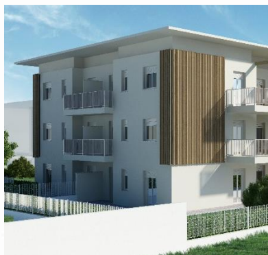
Particolari dei rivestimenti di facciata con intonaco colorato e fibrolegno.
